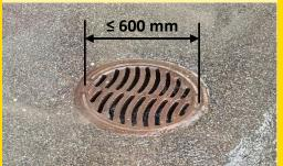
Sceller les bouches d'égouts. Poser le bac dessus et le remplir de quelques centimètres d'eau.
