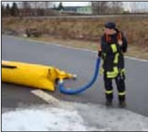
In schwierigem Gelände und bei Richtungsänderungen sollten die Schläuche vor dem Füllen mit Wasser immer mit Luft aufgeblasen werden.
