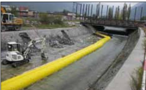
Für Bauarbeiten in der Bachsohle musste dieser kanalisierte Bergbach für Bauarbeiten häufig trocken gelegt werden. Die grösste Herausforderung dabei war, dass der
