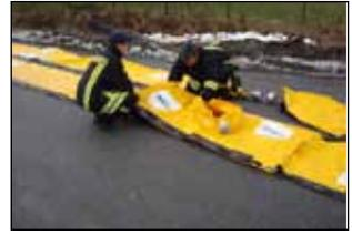
In der Längsrichtung werden die Schläuche mit der Verbindungsmanschette gekoppelt.
