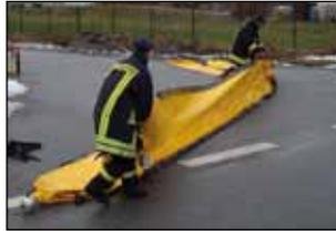
Nach dem Ausrollen werden die Schläuche ausgefaltet.
